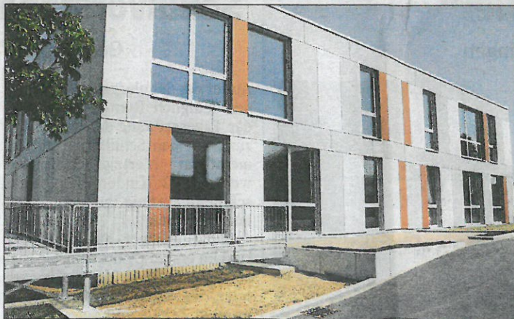
Die aus 30 Modulen bestehende Schule wurde nach den Plänen des Architekturbüros Jean Theisen errichtet.
