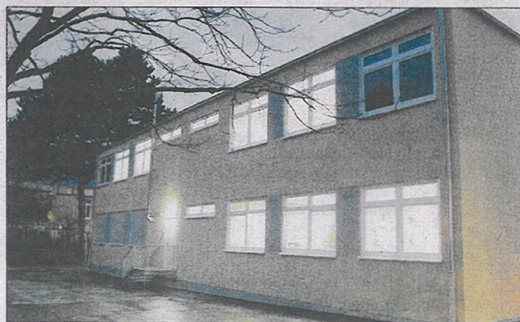
16 Module wurden in nur zehn Wochen zum neuen Foyer zusammengesetzt.
